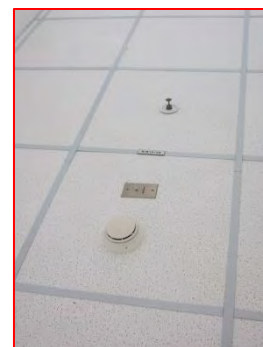
ภาพที่ 2.2-1(54) อุปกรณ์ตรวจจับความร้อน
