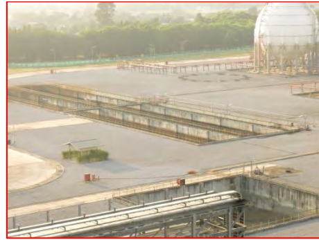
ภาพที่ 2.2-1(25) บ่อรวบรวมน้ำมัน (Oily Collection Sump)
