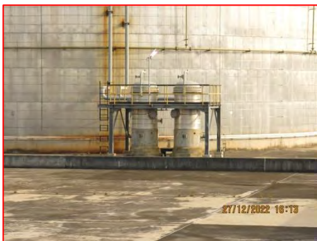
ภาพที่ 2.2-1(16) ตัวดูดซับด้วยถ่าน (Activated Carbon Canister) ที่บริเวณถังเก็บสารอินทรีย์
