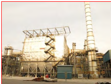
ภาพที่ 2.2-1(9) Electrostatic Precipitator (ESP) บริเวณปล่อง (53A001)
