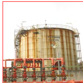
ภาพที่ 2.2-1(31) ถังรวบรวมน้ำมัน (Slop Tank)
