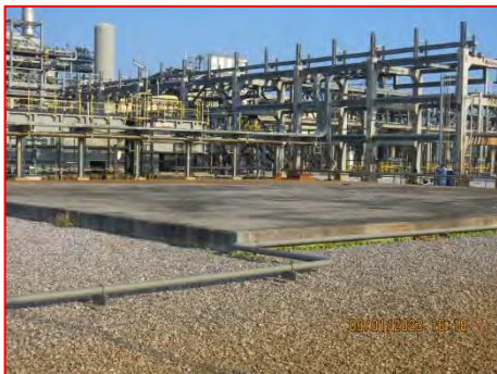
ภาพที่ 2.2-1(22) บ่อรวมน้ำมันปนเปื้อนน้ำมัน (Common Oily Water Basin)
