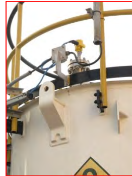
ภาพที่ 2.2-1(70) อุปกรณ์วัดระดับ (Level Indicator)
