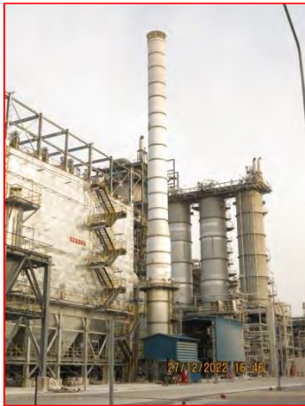
ภาพที่ 2.2-1(3) ปล่อง Regeneration System Flue Gas Stack (53A001)
