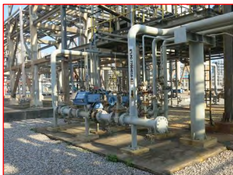
ภาพที่ 2.2-1(67) Emergency Isolation Valve
