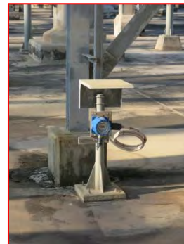
ภาพที่ 2.2-1(72) Gas Detector บริเวณลานถัง
