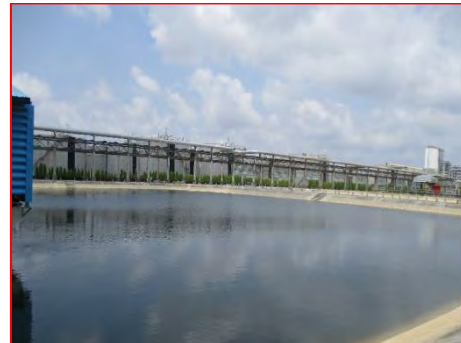
ภาพที่ 2.2-1(21) บ่อพักน้ำทิ้งหลังการบำบัด (Holding Pond)
