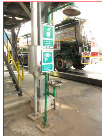
ภาพที่ 2.2-1(60) อ่างล้างตา และฝักบัว
