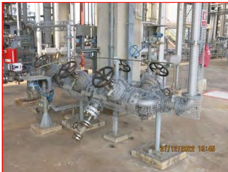
ภาพที่ 2.2-1(77) ตะแกรงเหล็ก (Personal Protection)
