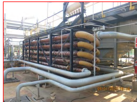
ภาพที่ 2.2-1(23) ระบบบำบัดเบื้องต้นแบบแยกน้ำ และน้ำมันด้วยตัวกลางแบบแผ่นขนาน (CPI) และระบบบำบัดเบื้องต้นแบบใช้อากาศแยกน้ำ ออกจากราน้ำมัน (IAF)
