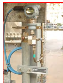
ภาพที่ 2.2-1(68) อุปกรณ์วัดความดัน (Pressure Indicator)
